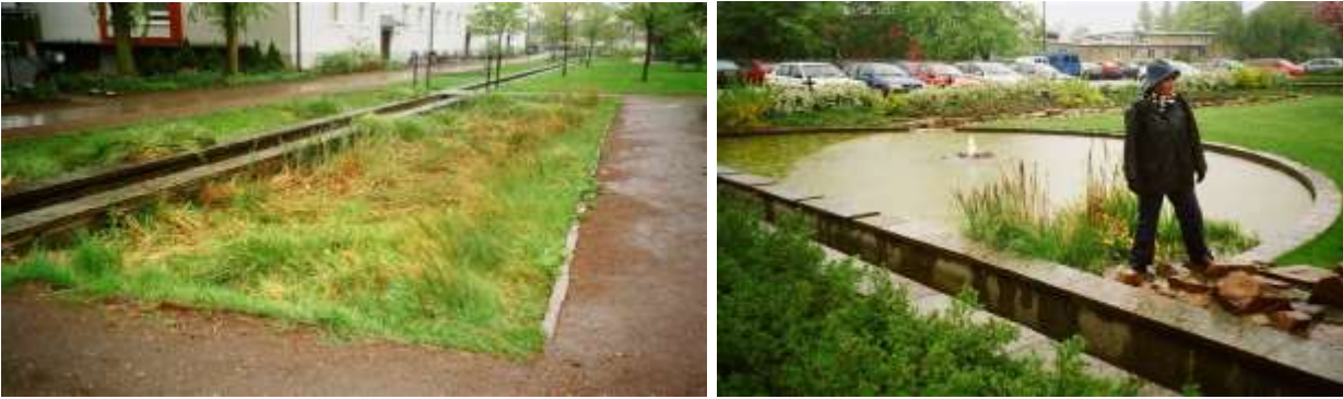
33., 34.attēls. Mākslīgā mitraine vienotā sistēmā ar lietusūdeņu kanālu un lietusūdeņu baseins ar strūklaku. Ūdens augiem baseinā ir pietiekošā daudzumā. Baseina ūdeni var izmantot arī līdzās esošo augu mitrināšanai.
